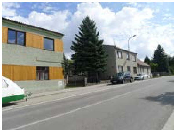
Zástavba po pravé straně D3 (výpočt. bod PO1)
