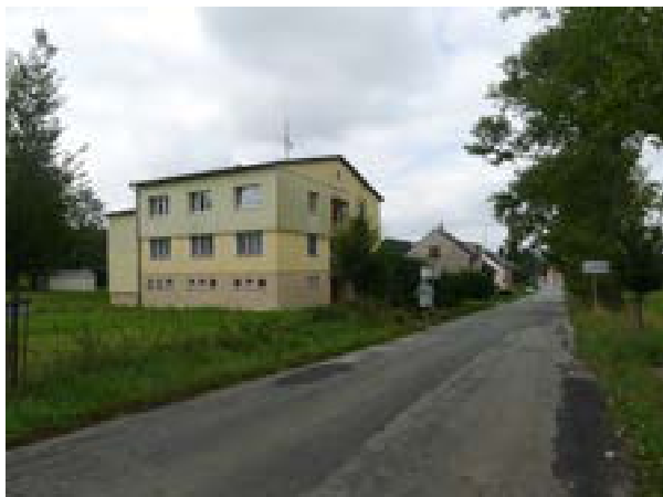
Bytový dům čp. 30 (výpočt. bod HL5)
